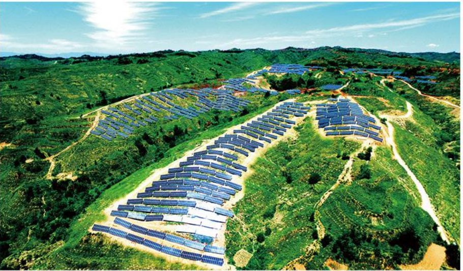
榆社光伏帮扶项目
