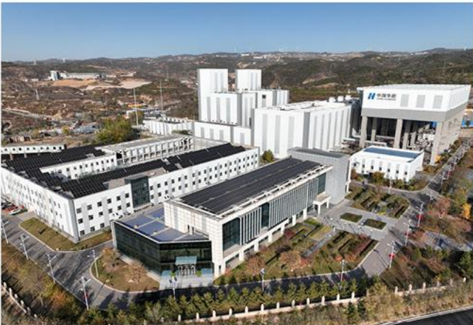
东山燃机电厂屋顶光伏
