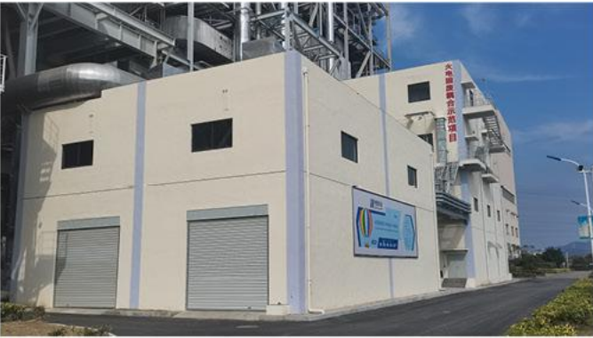
火电固废耦合示范项目
