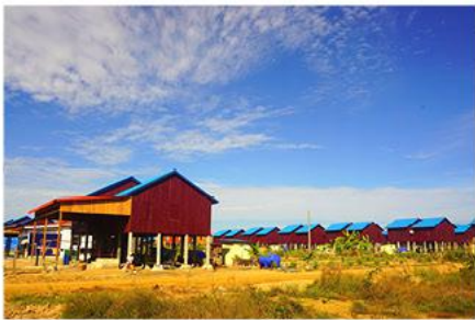
桑河二级水电站移民村
